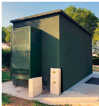
Nœud de Raccordement Optique (NRO)
