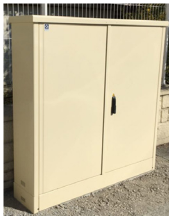
Sous Répartiteur Optique (SRO)
